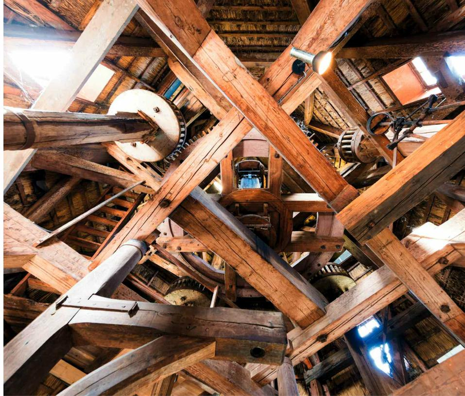
▲ Ein Blick nach oben zeigt die massive Holzbalkenkonstruktion. Die Räder werden durch die Mühlenflügel in Bewegung gesetzt.
